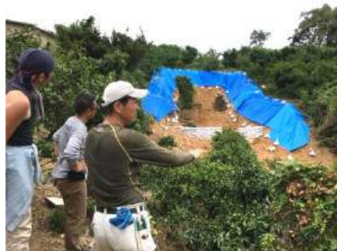
7月豪雨のあと、被害を受けた豊共園に職員が復旧作業の支援ボランティアを行いました。
